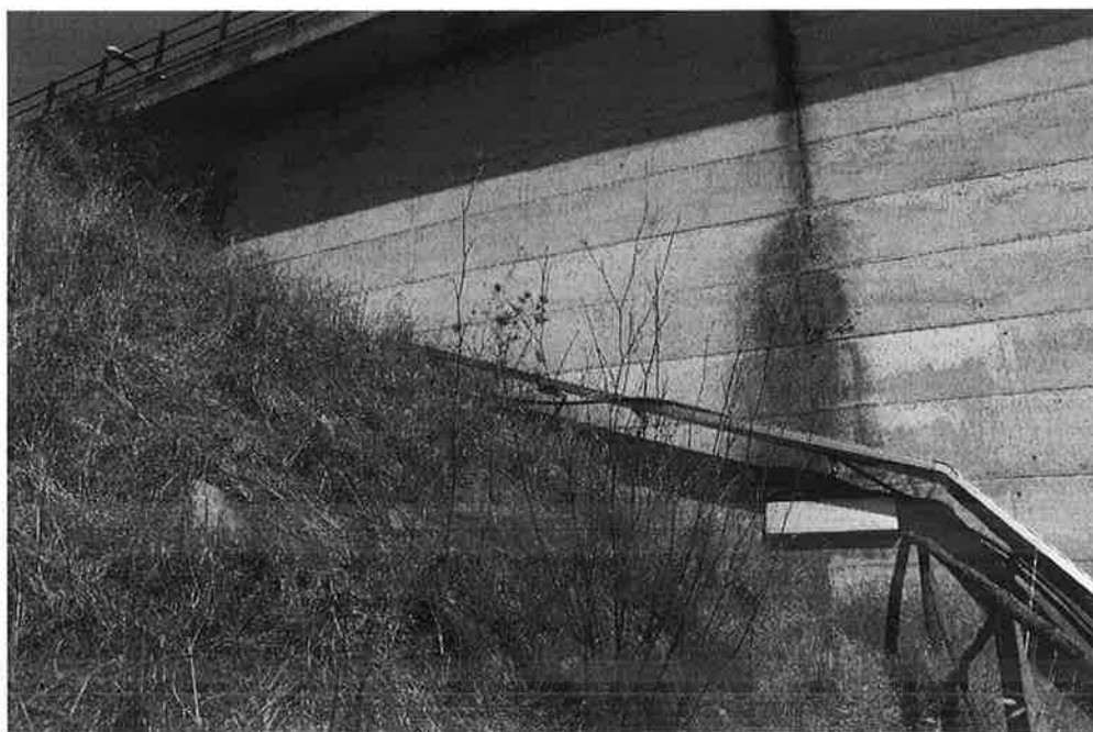
11) Vista paramento di valle della diga e della canala in acciaio inox da utilizzare per passaggio cavo Profibus
