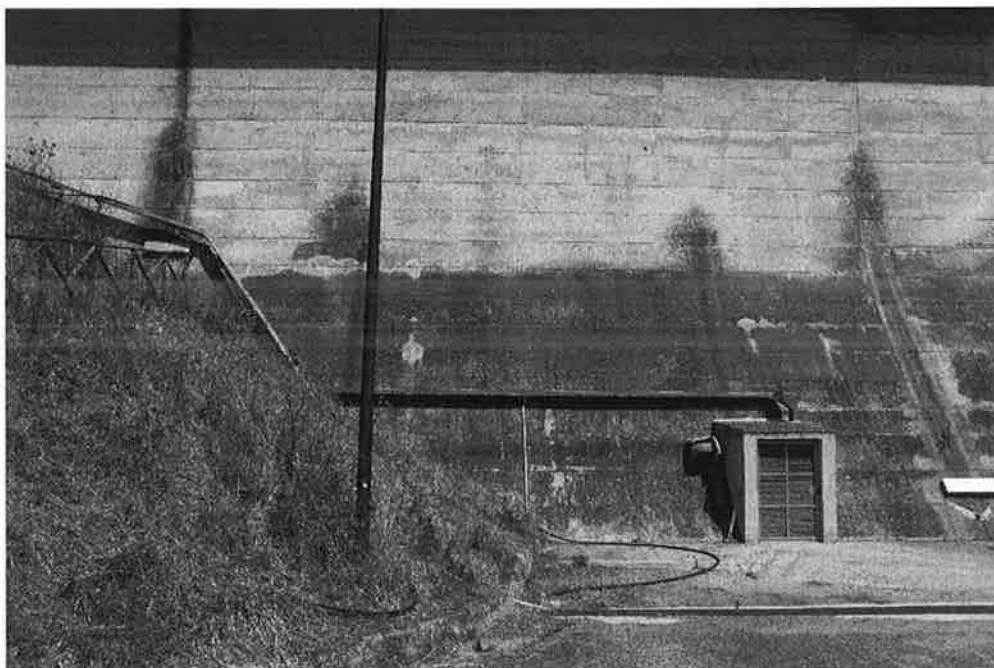
10) Vista porta di uscita del cunicolo e relativa canala in acciaio inox da utilizzare per passaggio cavo Profibus
